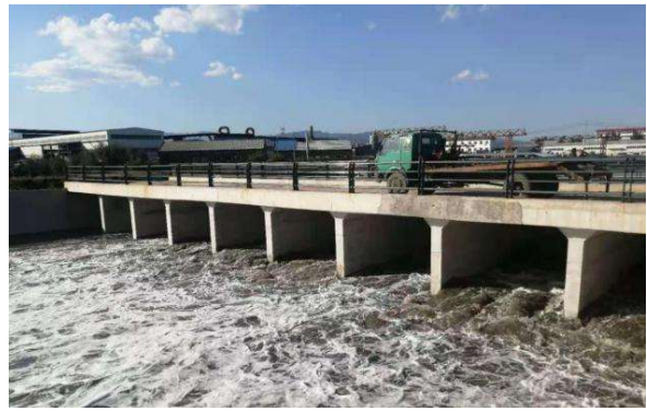
图 19 新建的潇河泵站
