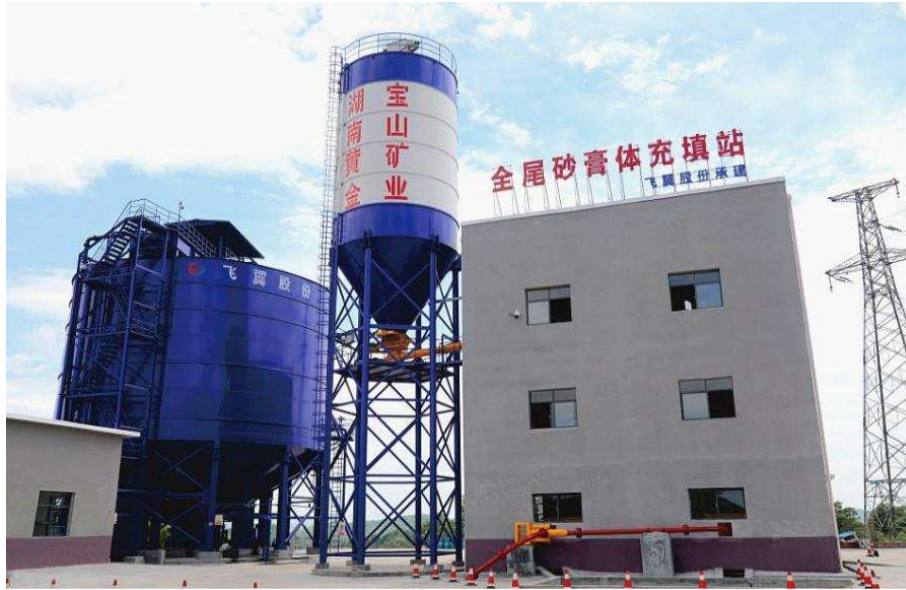
图 52 宝山矿业引进全球先进的膏体充填工艺对井下采空区实施充填
