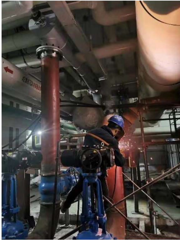
图 22 嘉节燃气热电厂适应性供热系统技术改造
