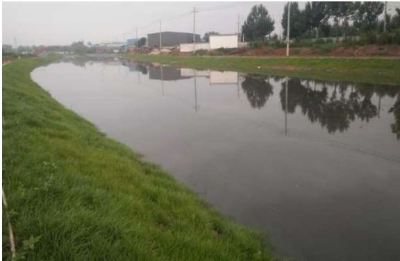
图 18 洛阳桥段堤防工程
