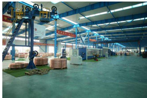
图 54 郴州正威新材料科技城铜基一期项目正式投产
