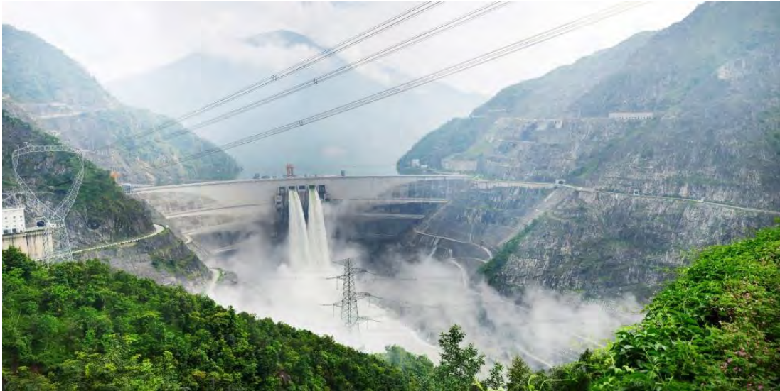
图 111 总装机容量 420 万千瓦小湾电站
