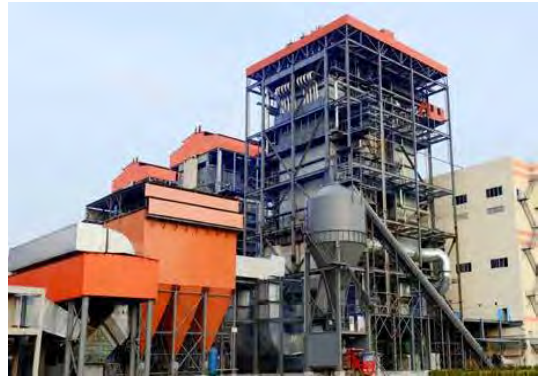
图 30 TG-550/9.8M 型循环流化床锅炉 (第三代超低排放型)
