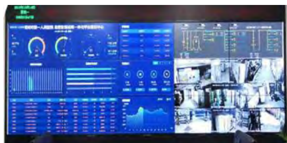
图 102 市第一人民医院运用智慧运维平台监控自来水消耗情况
