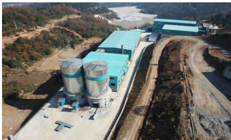
图 90 “改性钨尾矿微粉材料”可加工为绿色建材水泥混合材和混凝土掺和料
