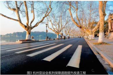
图3 杭州亚运会系列保障道路提升改造工程
